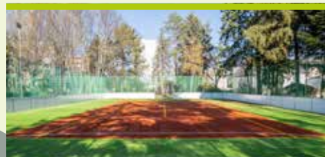
Dokončili sme prvú fázu obnovy športoviska pri SPŠ elektrotechnická Piešťany (november 2021)
