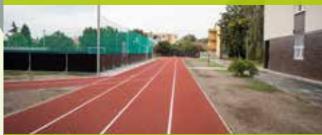
Na SOŠ stavebnej s VJM v Dunajskej Strede sme vynovili vonkajšie športovisko (september 2022)
