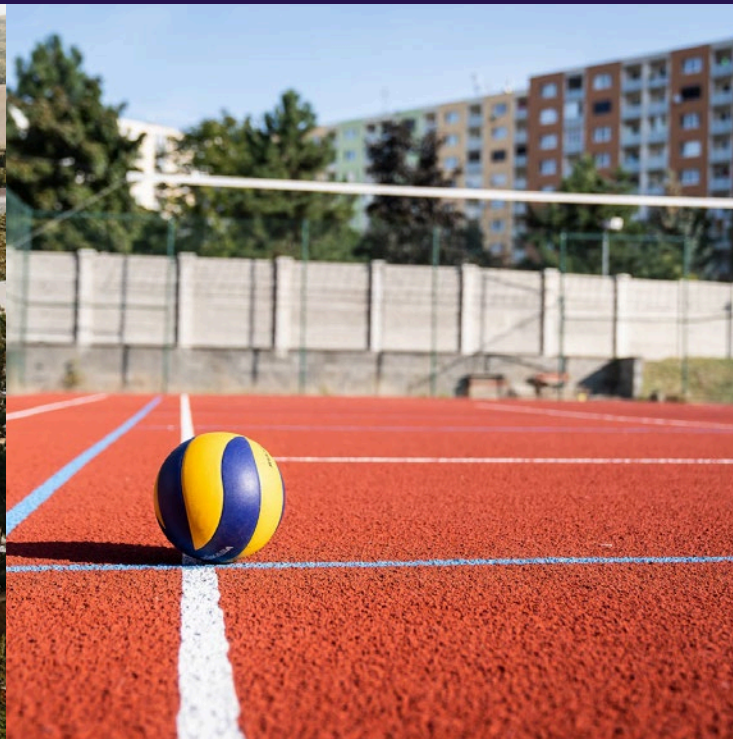
Obnovili sme športovisko na Gymnázium Jána Hollého v Trnave
