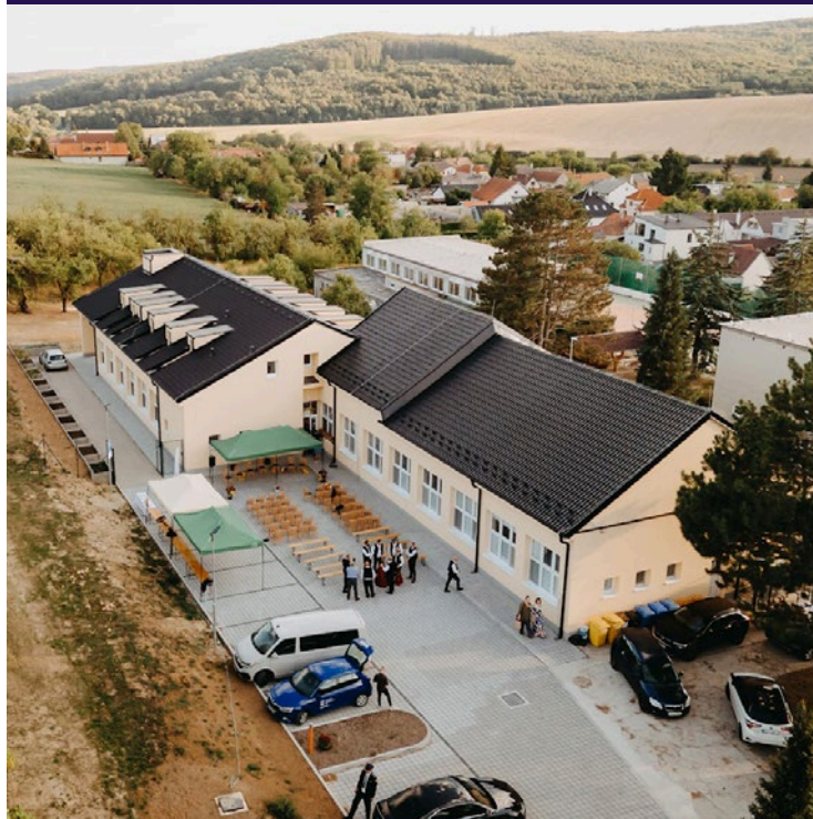
Vybudovali sme nové centrum pre autistov na Dobrej Vode
