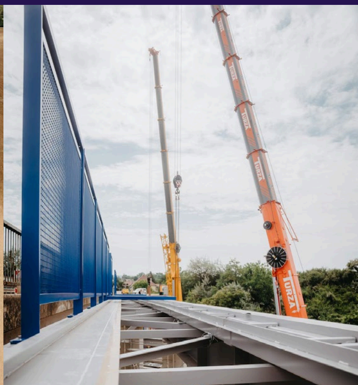
Postavili sme župný cyklomost pri Zavare
