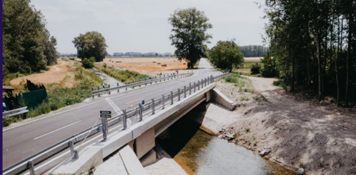
Zrekonštruovali sme most v Trsteneň na Ostrove
